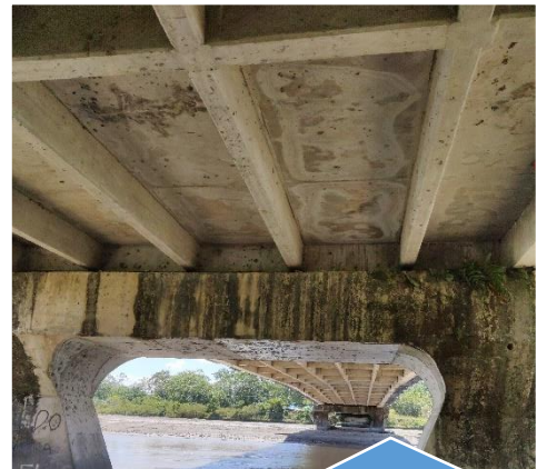
Apoyos de la super estructura en concreto
