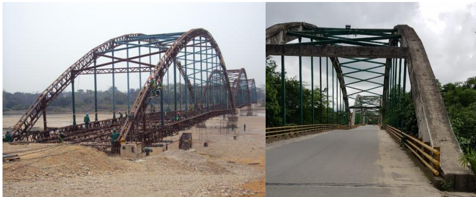
Figura 5 Arco superior de estructura mixta Fuente: Propia
