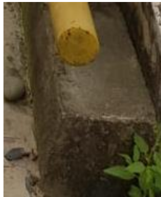
Figura 17 Bordillo Fuente: Propia
