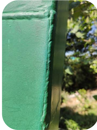
Figura 33 Soldadura en elemento tipo Arco Fuente: Propia
