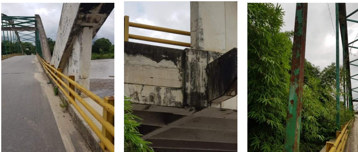
Figura 2 Registro fotográfico inicial del estado físico del puente Fuente: Propio
