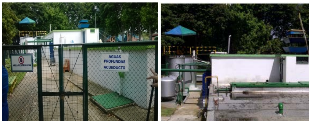
Ilustración 4: Planta de tratamiento de agua potable del Club Izquierda vista desde la puerta de entrada. Derecha vista sobre el cuarto de almacenamiento. Fuente: El Autor
