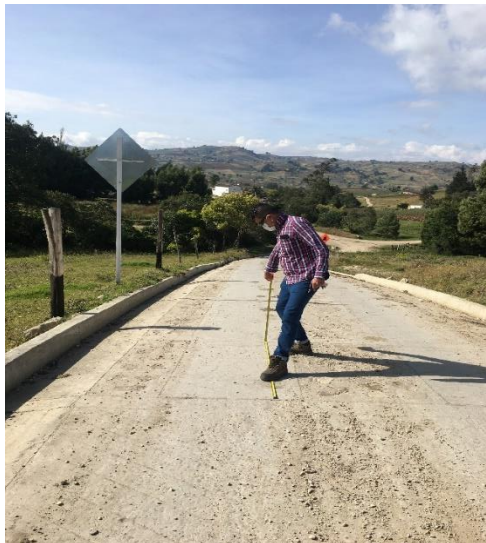
Ilustración 14. Inspección visual de la placa huella.
