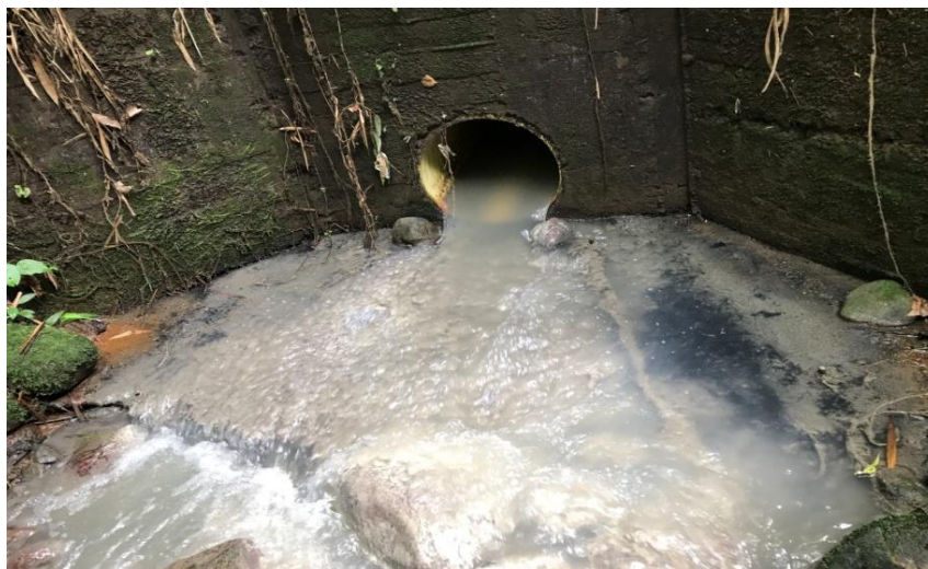
Figura 1. Vertimiento de agua residual doméstica por la zona suroccidental del municipio de Restrepo, Meta. Por Eduardo Ardila y Diego Rojas, 2018.
