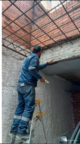
Imagen 1. Definición de áreas a inspeccionar.
