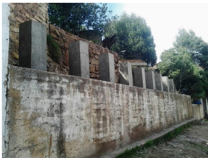
Imagen. 17 Pilotes desencofrados
