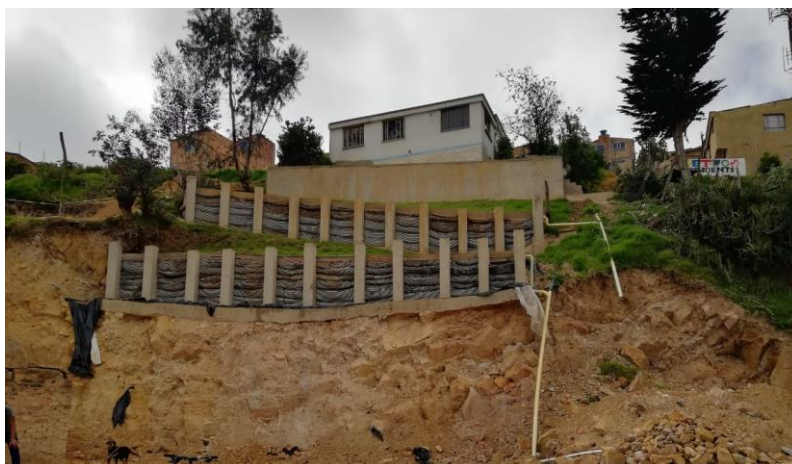
Imagen. 9 Empradización de muros mecánicamente estabilizados con geotextil y geomalla
