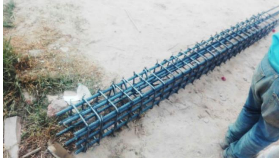
Imagen. 8 Armado de acero de pilotes cuadrados.
