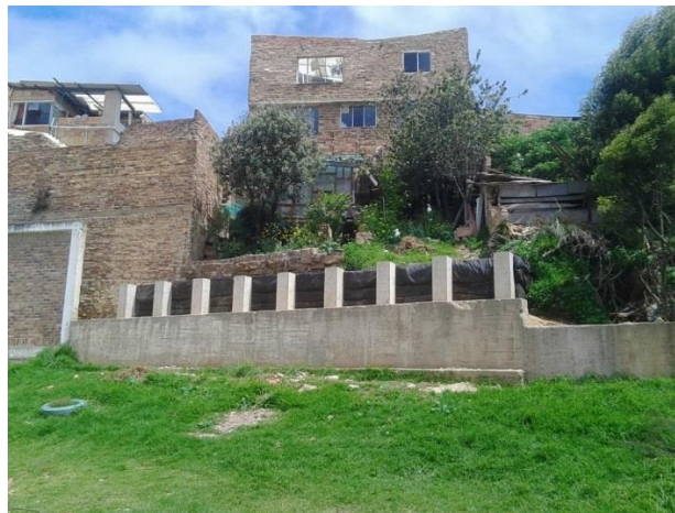
Imagen. 18 Sistema de pilotes y muro con geotextil finalizados
