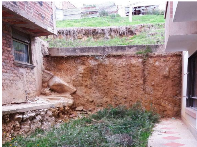
Imagen. 19 Barrio el rodeo - Cara del talud
