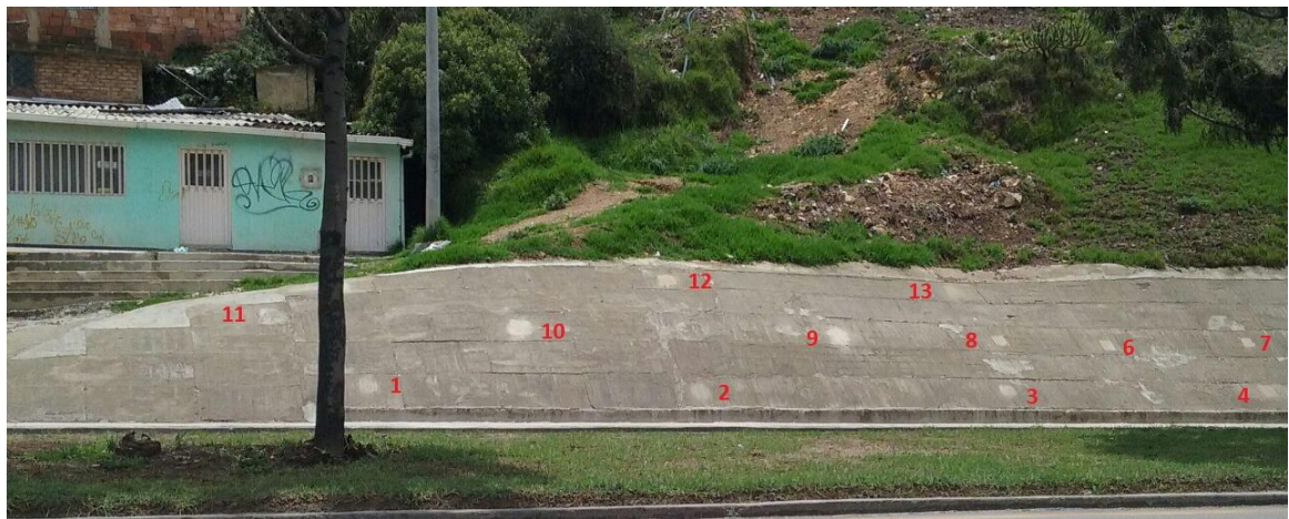
Imagen. 3 Vista frontal del talud de la avenida oriental.
