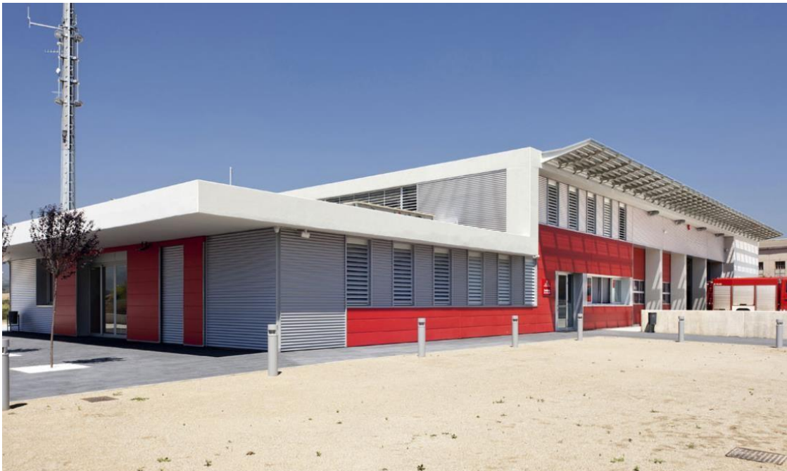
Figura 32: Estación de bomberos de Valls
