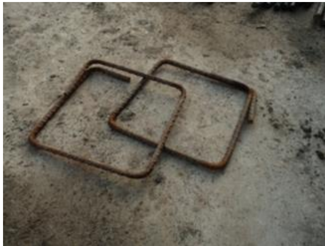
Figura 17. Fallos generados durante el proceso de ejecución de una mampostería confinada (mal figurado del acero)
