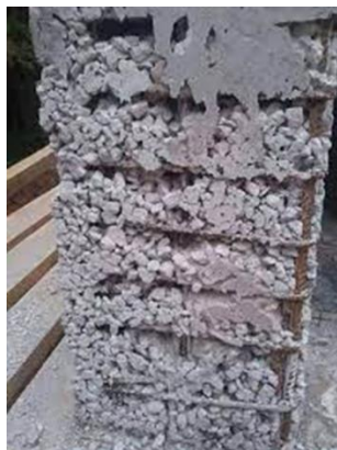
Figura 19. Fallos generados durante el proceso de ejecución de una mampostería confinada (hormigoneo)
