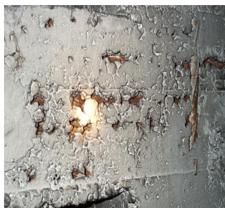
Figura 19. Fallos generados durante el proceso de ejecución de una mampostería confinada (hormigoneo)
