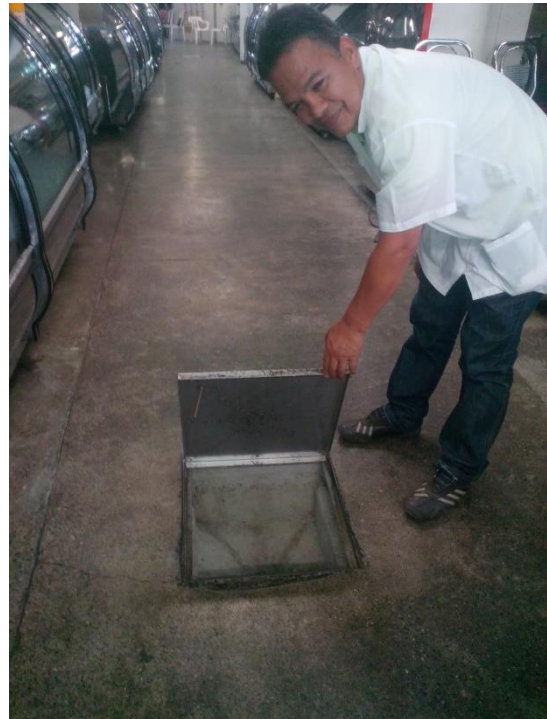
Fotografías 63 y 64, Trampa de grasa pasillo de carnes y cárnicos. Y sifonería en expendio de carnes Abril de 2015
