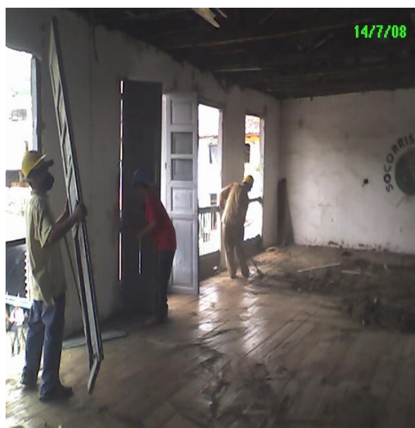
Foto 13, La Demolición: En ella participaron los comerciantes como aportantes de los recursos para efectuar una demolición controlada, adecuada y que no revistiera peligro para la población ni los trabajadores, esto fue posible también, gracias al apoyo de la secretaría de planeación municipal, 14 de julio de 2008
