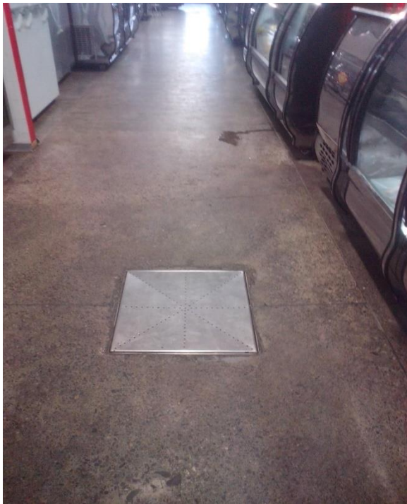
Fotografías 63 y 64, Trampa de grasa pasillo de carnes y cárnicos. Y sifonería en expendio de carnes Abril de 2015
