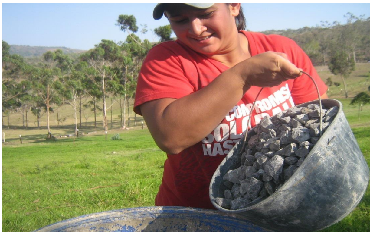
Aplicación de grava en el filtro
