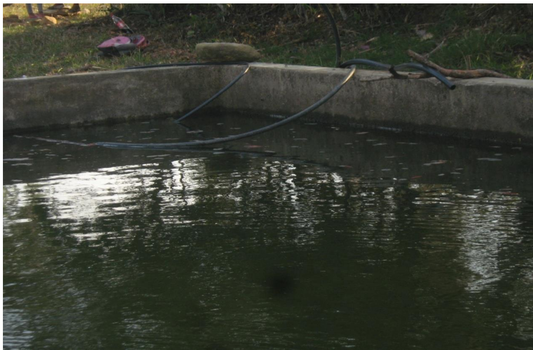
Tanque de abastecimiento en concreto.
