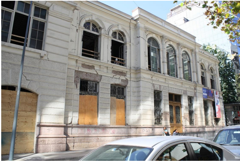
Figura 38: Antes de intervención, Edificio Chile. Fuente: (Franco, 2014)
