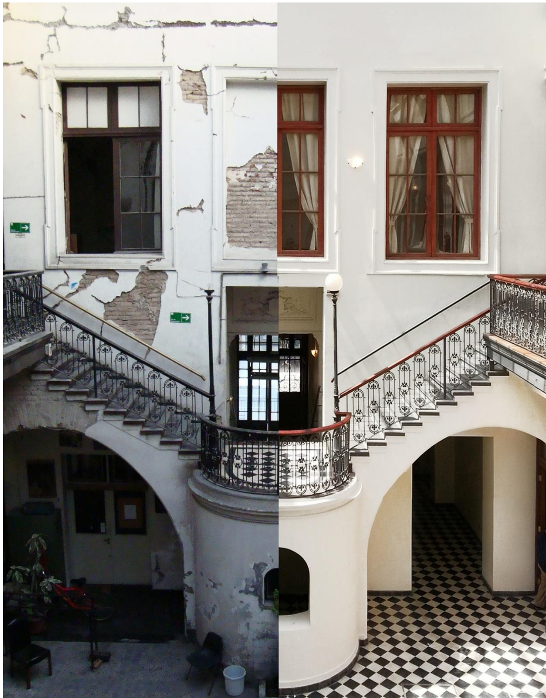
Figura 37: Antes y Después, Edificio. Fuente: (Franco, 2014)
