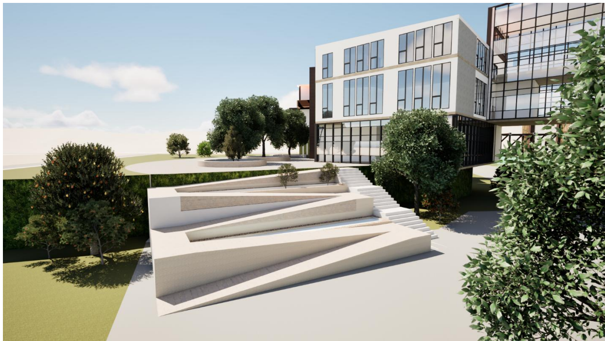
Figura 58 Imagen Rampas Pendiente 8% y escaleras
