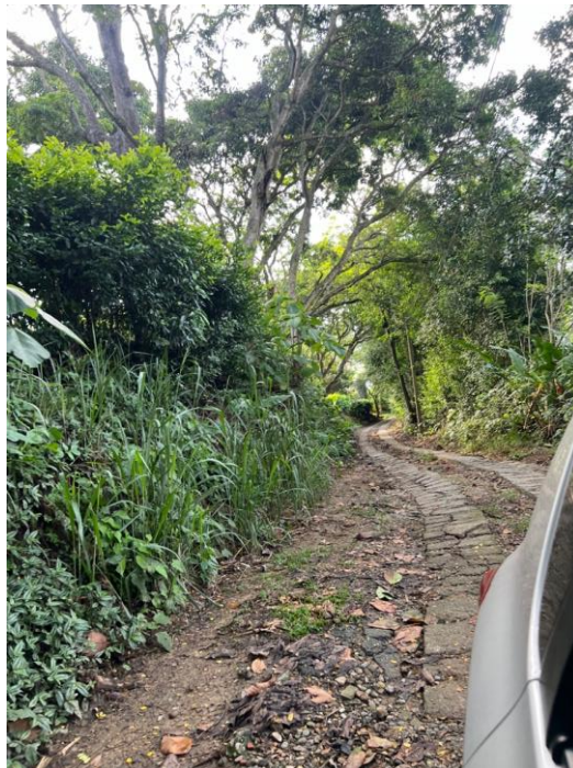
Figura 23. Fotografía estado actual de la carretera
