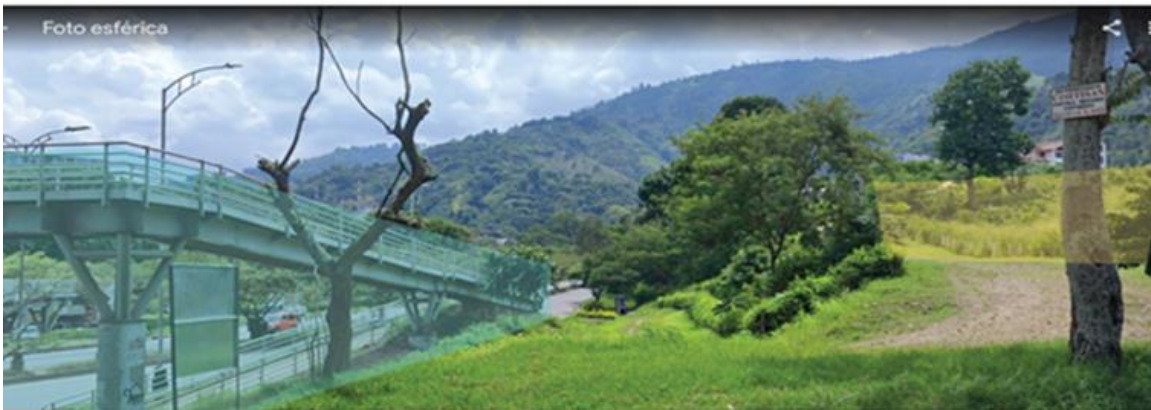
Figura 22. Puente peatonal Carrera 14
