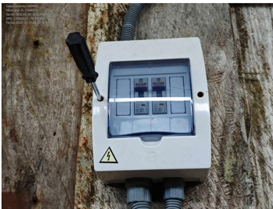
Imagen 5. Desatornillador utilizado para destapar las cajas de breaker.
