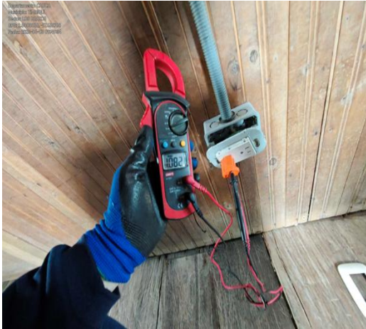
Imagen 16. Se encontró el tomacorriente sin tornillos, se le recomienda al usuario hacerlo adecuar por seguridad.
