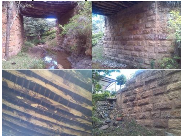
Imagen 4 inspección de puente vehicular en madera
