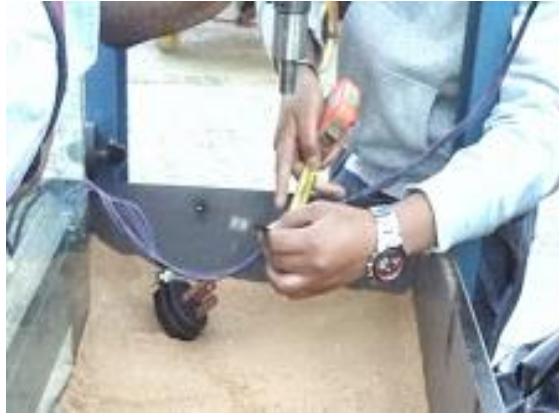
Foto 2-12 Conexión eléctrica del motor
