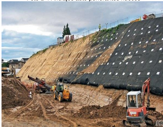
Foto 1-4 Anclajes auto perforantes huecos
