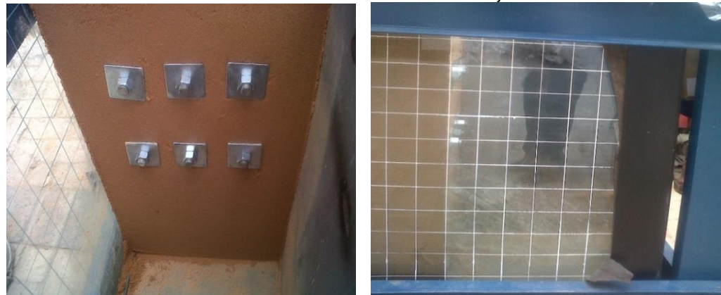
Foto 3-29 Talud reforzado con 6 anclajes
