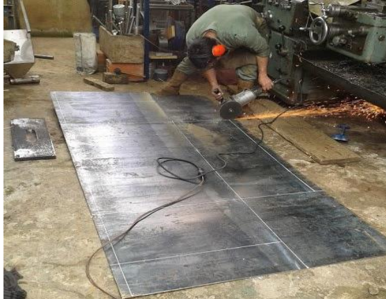
Foto 2-5 Medición y corte de la lámina para el cajón
