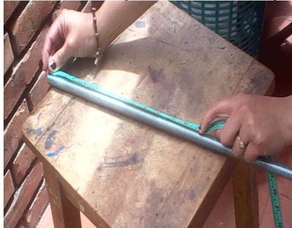
Foto 2-16 Medición y corte del tendón del anclaje
