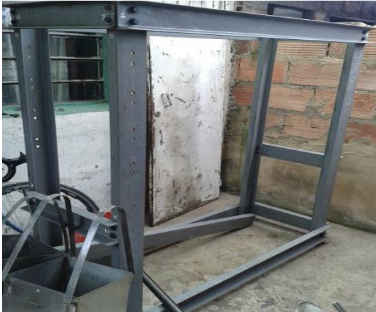
Foto 2-4 Construcción del marco
