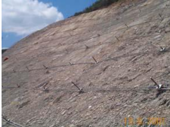
Foto 1-6 Sistema Tecco Mesh G-65
