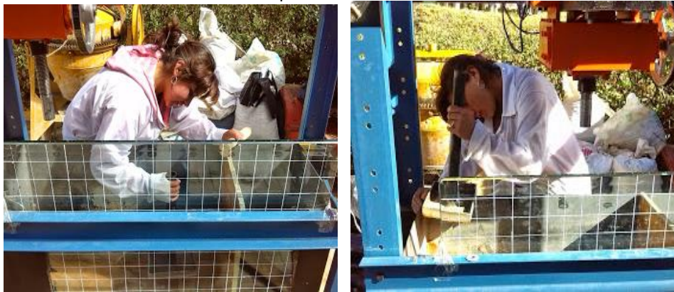
Foto 3-14 Compactación del suelo con martillo
