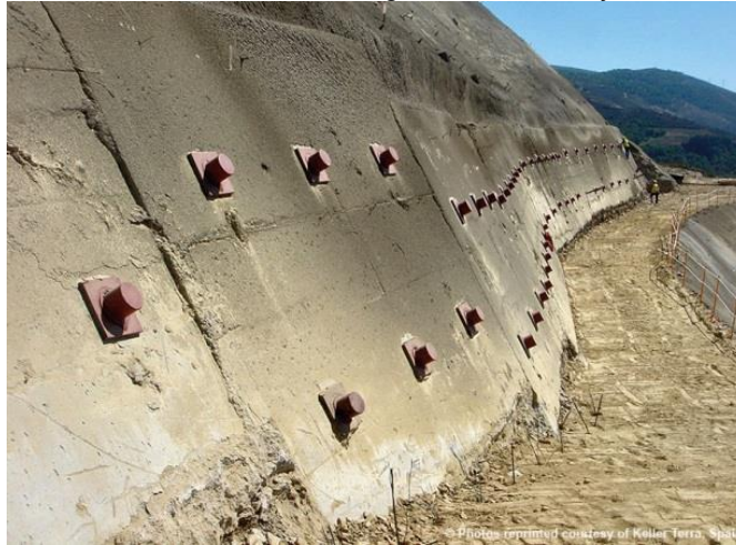
Foto 1-3 Pantallas aseguradas con anclajes
