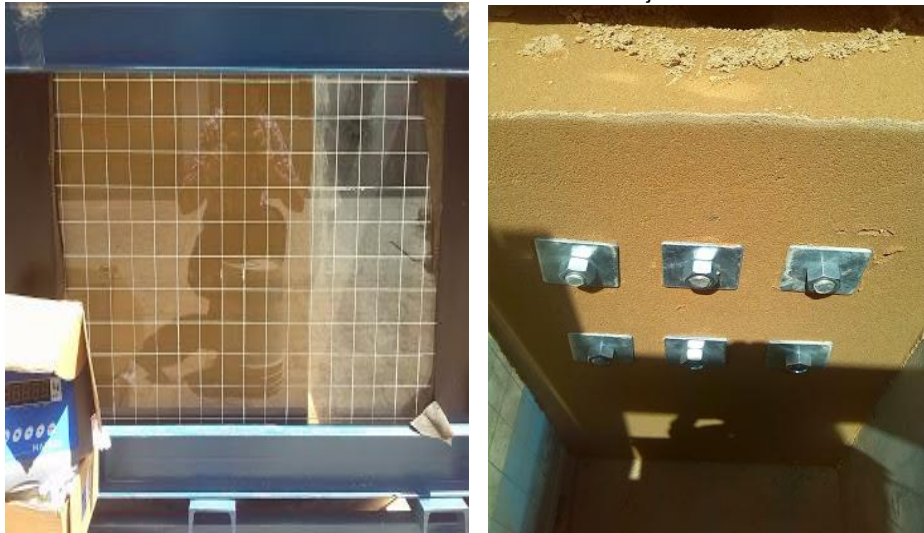
Foto 3-38 Talud anclado con 6 anclajes
