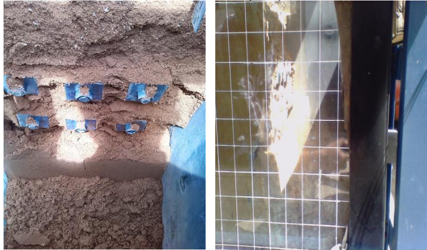
Foto 4-11 falla vista principal
