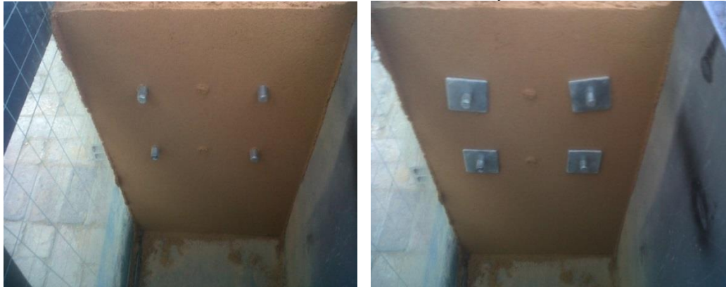
Foto 3-35 Talud reforzado con 4 anclajes
