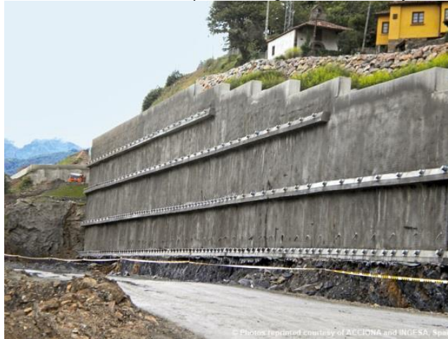
Foto 1-2 Pantalla de pilotes asegurada con anclajes
