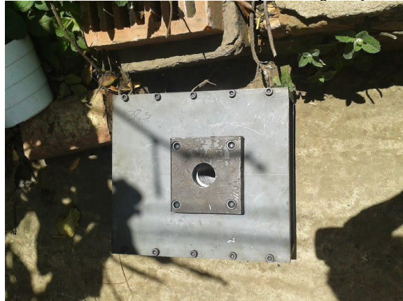
Foto 2-6 Construcción de la caja de engranajes
