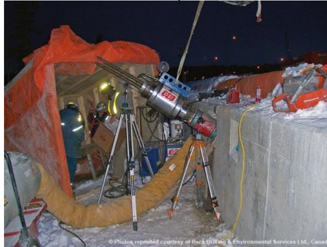
Foto 1-1 Anclaje de cable
