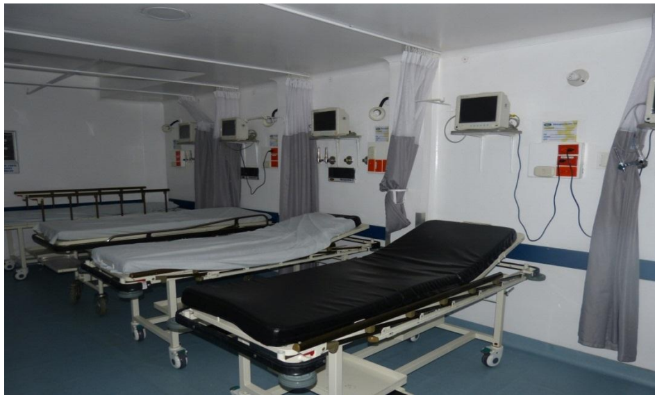
Figura 19. Zonas de equipos médicos-uci-salas de recuperación monitores multiservicios.
