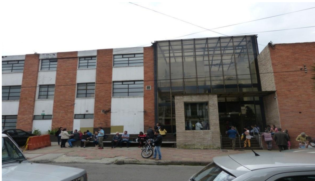
Figura 5. Fachada principal de la Clínica San Diego. Primera edificación que se construyó completamente.
