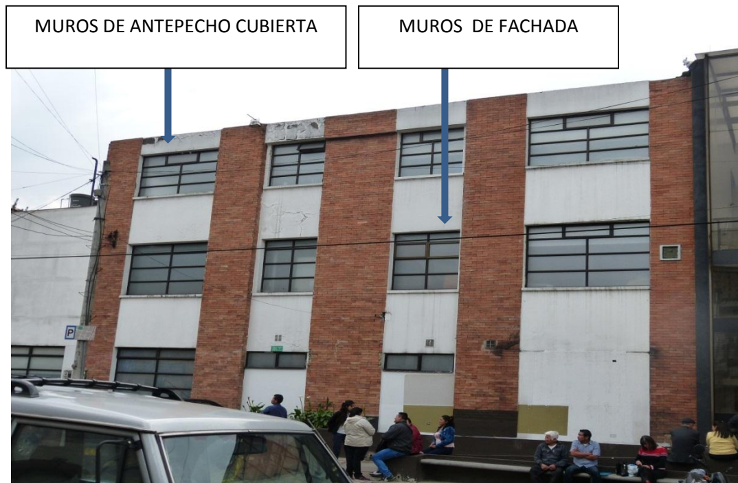
Figura 34. Zona de mampostería en la fachada.
