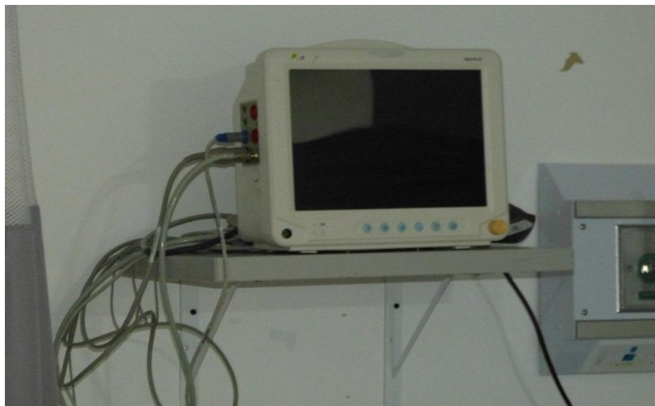
Figura 20. Zonas de equipos médicos-uci-salas de recuperación monitores multiservicios.
