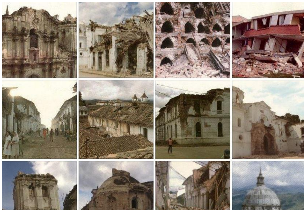
Figura 10. Daños estructurales en Popayán ante el sismo de 1983.
