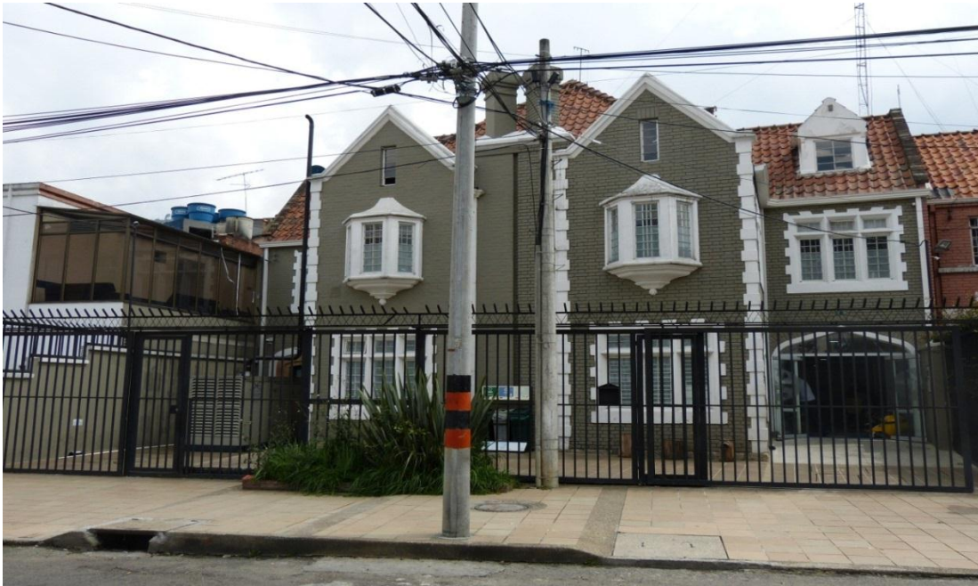
Figura 6. Fachada principal expansión hospitalización. Segunda edificación que se adecuo para su operación.
