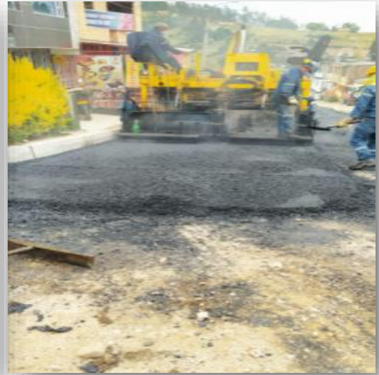
Ilustración 27. Fotografía 37,38 y 39. Construcción de carpeta asfáltica.
