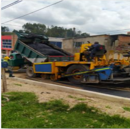
Ilustración 27. Fotografía 37,38 y 39. Construcción de carpeta asfáltica.
