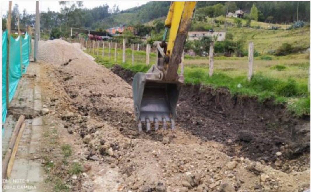
Ilustración 39. Fotografía 60. Demolición de placas macizas
