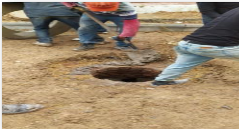
Ilustración 13. Fotografía 14. Renivelación de pozos
