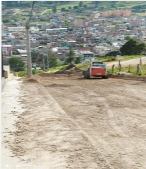
Ilustración 31. Fotografía 46 y 47. Relleno con material de afirmado
