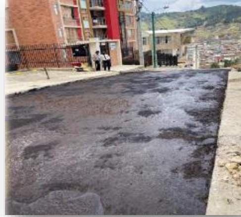
Ilustración 36. fotografía 54 y 55. Imprimación con emulsión asfáltica
