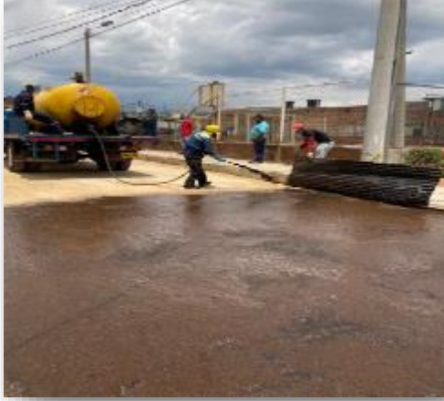
Ilustración 36. fotografía 54 y 55. Imprimación con emulsión asfáltica
