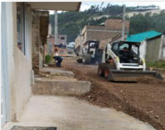
Ilustración 11. Fotografía 10 y 11. Sub Base granular
