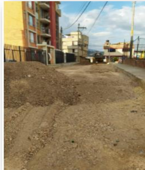
Ilustración 31. Fotografía 46 y 47. Relleno con material de afirmado
