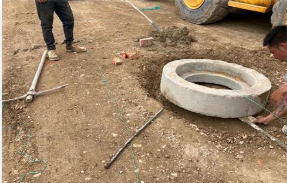
Ilustración 24. Fotografía 33. Nivelación de pozo
