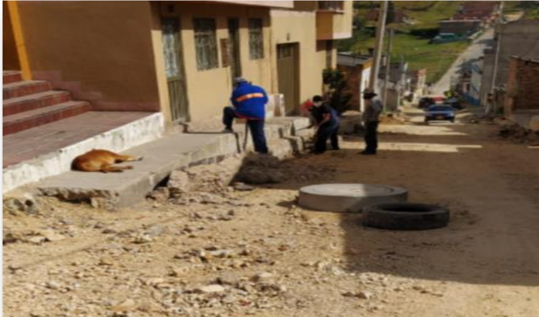
Ilustración 58. Fotografía 91, 92 y 93. Demolición de andenes y retiro de escombros.
