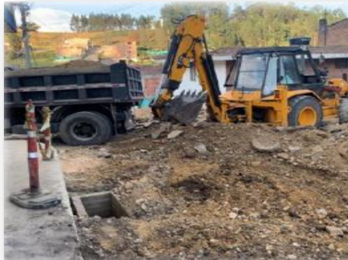
Ilustración 6. Fotografía 1 y 2. Demolición de placas macizas de concreto
