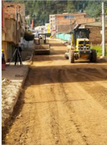
Ilustración 23. Fotografía 31 y 32. Extendida y riego de base granular
