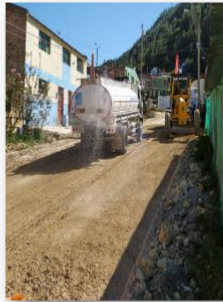
Ilustración 23. Fotografía 31 y 32. Extendida y riego de base granular
