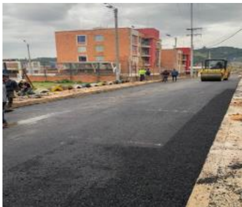
Ilustración 37. Fotografía 56 y 57. Construcción de la carpeta asfáltica
