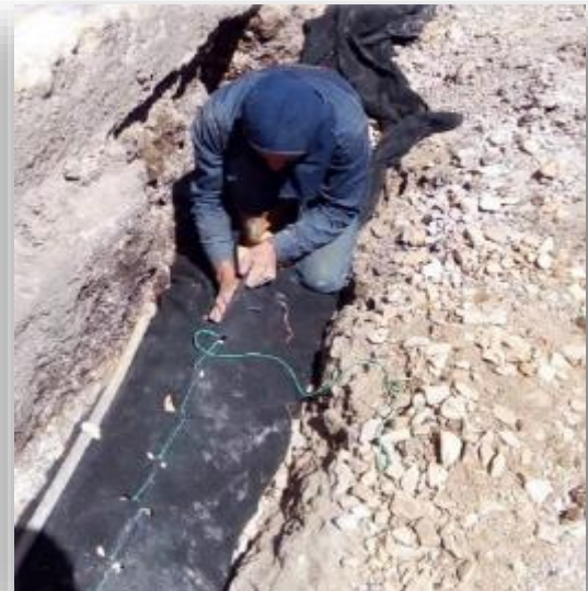
Ilustración 8. Fotografía 5 y 6. Construcción de filtro
