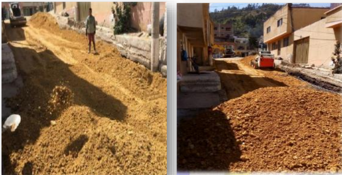
Ilustración 9. Fotografía 7 y 8. Relleno con material de afirmado
