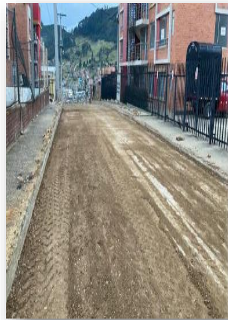
Ilustración 34. Fotografía 51 y 52. Relleno con Base granular
