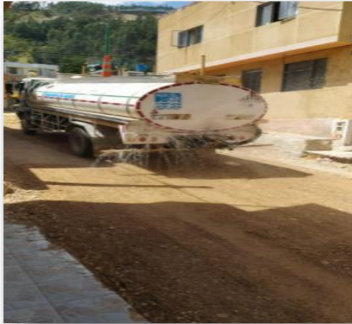
Ilustración 12. Fotografía 12 y 13. Base granular
