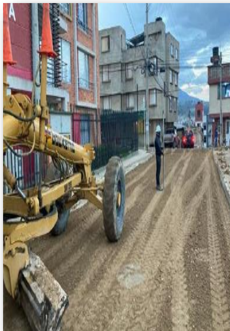
Ilustración 34. Fotografía 51 y 52. Relleno con Base granular
