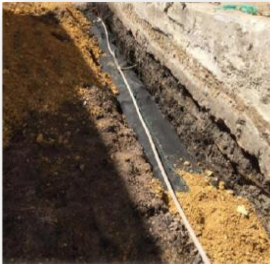
Ilustración 8. Fotografía 5 y 6. Construcción de filtro
