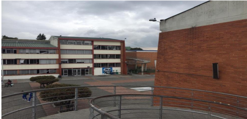
Gráfico 8: Infraestructura Colegio Ciudad de Bogotá, Sede A
