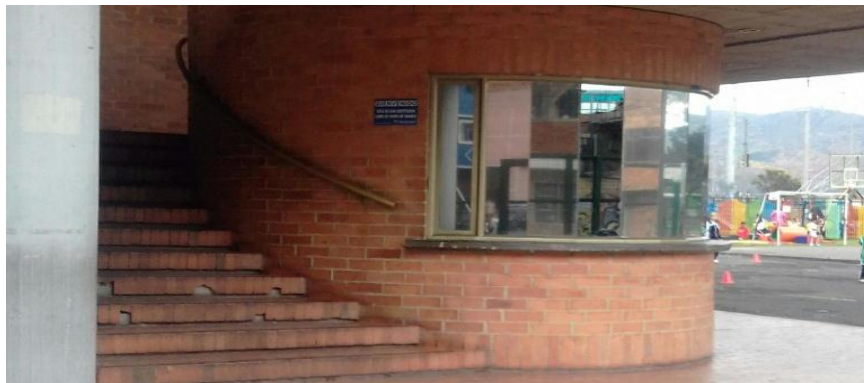
Gráfico 12: Infraestructura sede B primaria Colegio ciudad de Bogotá
