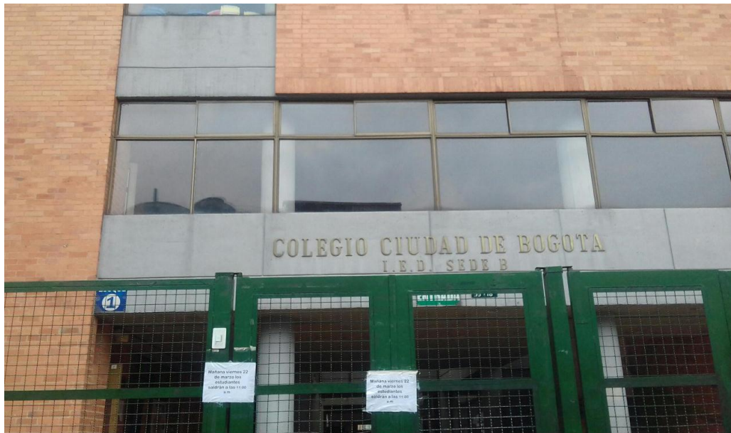
Gráfico 11: Infraestructura sede B primaria Colegio ciudad de Bogotá
