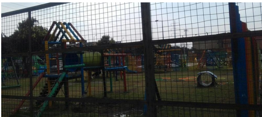
Gráfico 13: Infraestructura sede B primaria Colegio ciudad de Bogotá
