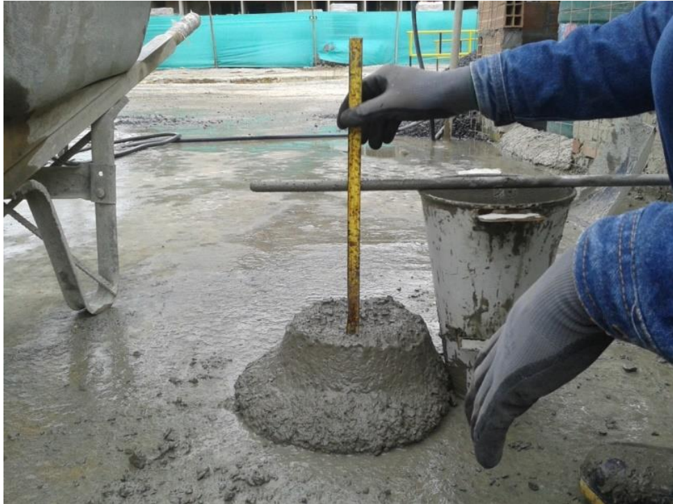
Fotografía 16. Prueba de asentamiento.
