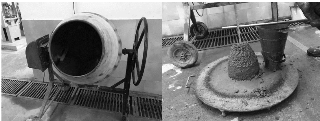
Figura 18. Elaboración concreto. (a) Mezcladora mecánica, (b) ensayo de asentamiento
