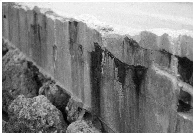
Figura 3. Corrosión Acero
