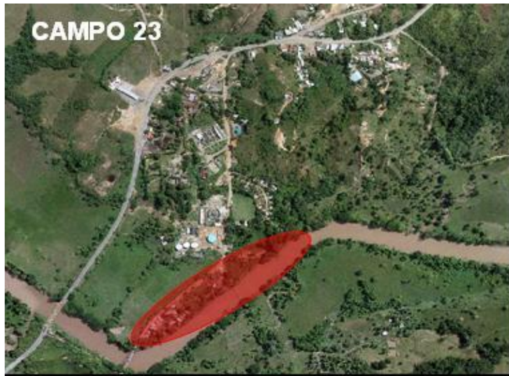
Figura 19. Campo 23. Área crítica sobre la Q. La Colorada. Fuente: elaboración oficina asesora de planeación Barrancabermeja 2012.
