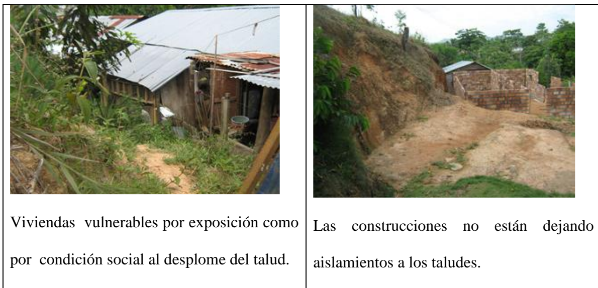
Figura 20. Imágenes zonas vulnerables en Campo 23. Fuente: elaboración del autor. 2016.
