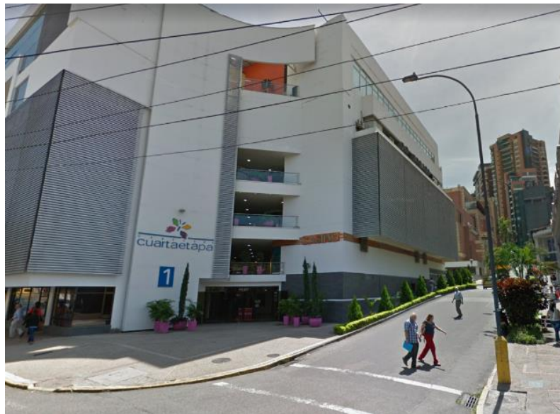
Figura 30 Acceso principal centro comercial cuarta etapa, Fachada original. Fuente:
