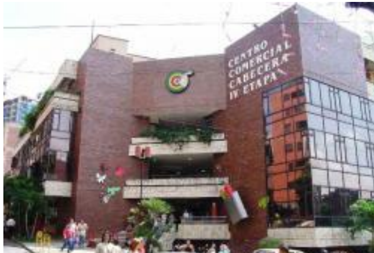
Figura 31 Acceso principal centro comercial cuarta etapa, Fachada original. Fuente:
