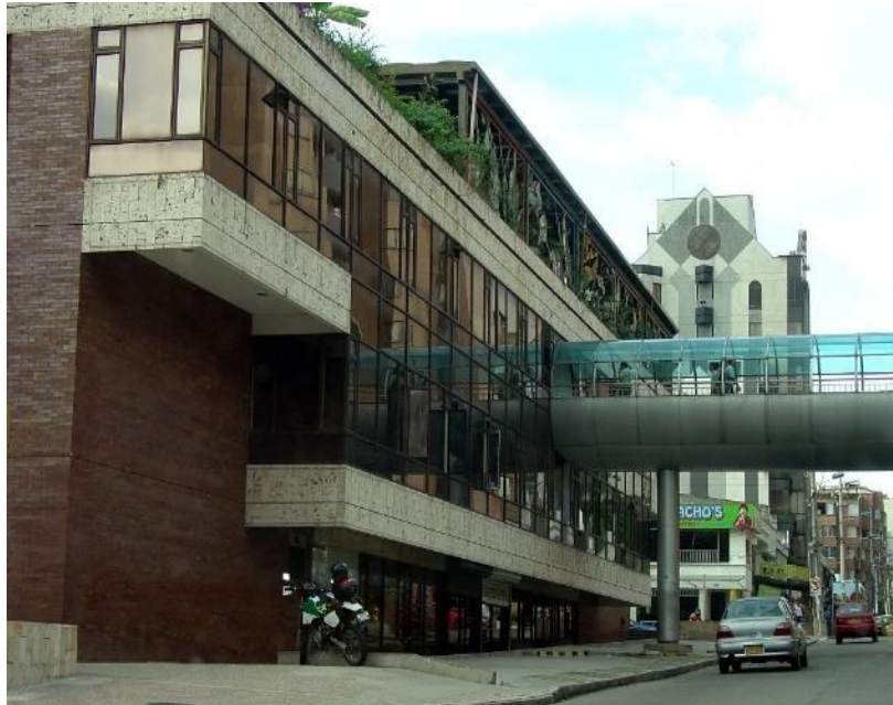
Figura 33 Fachada lateral original. Fuente: ImageShack.
