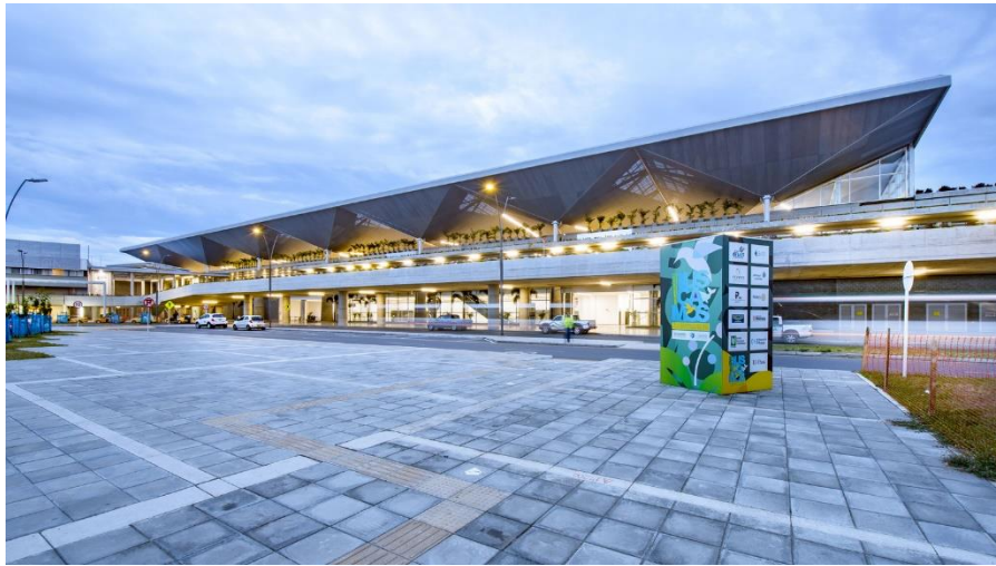
Figura 13 Fachada principal. Nuevo terminal internacional T2 aeropuerto internacional Alfonso Bonilla Aragón.
