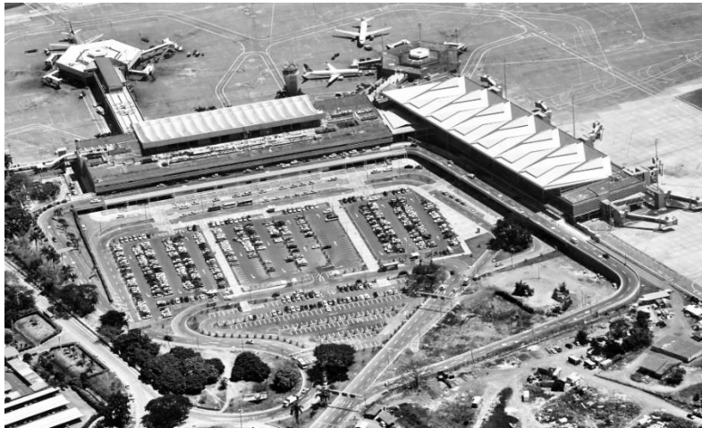
Figura 16 Vista general. Nuevo terminal internacional T2 aeropuerto internacional Alfonso Bonilla Aragón.
