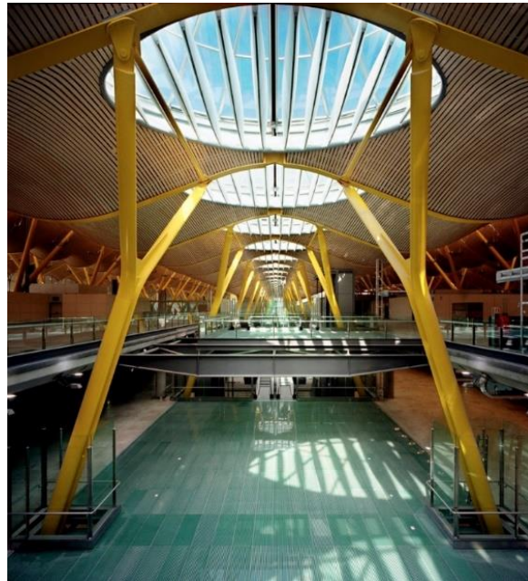
Figura 6 Vista interior. Terminal del aeropuerto Madrid/Barajas. Estudio Lamela + Richard Rogers partnership. (2005)
