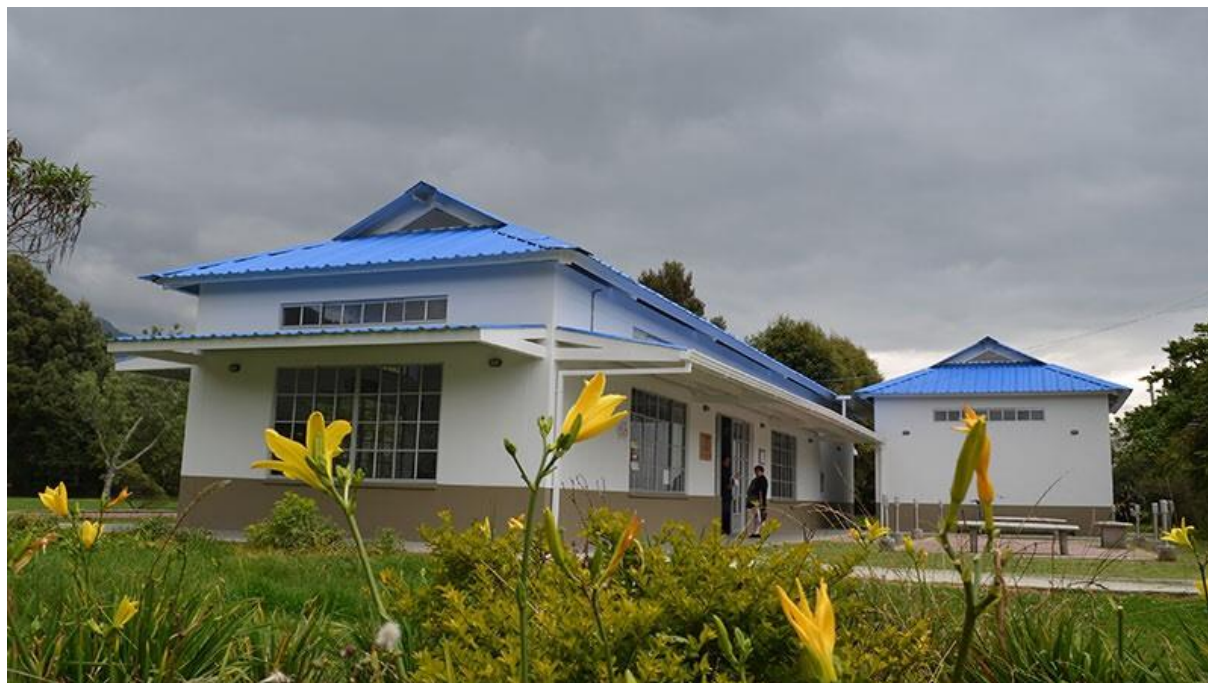
Figura 17. Fachada de la Biblioteca ya Construida
