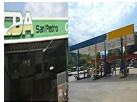
Fotografía 1. Estación de Servicio San Pedro kilómetro 7, vía Florida - Piedecuesta..
