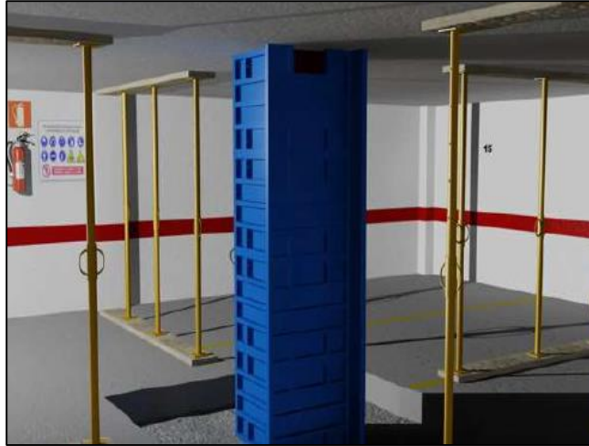
Ilustración 65 Encofrado de columna a emplear
