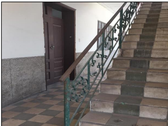
Ilustración 38 Pendiente escalera interna
