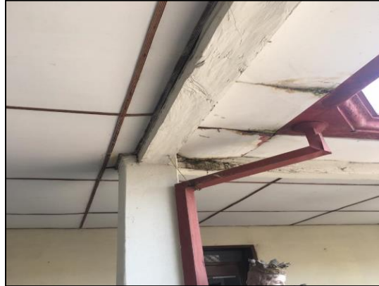
Ilustración 34 Nodo columna en concreto viga en madera
