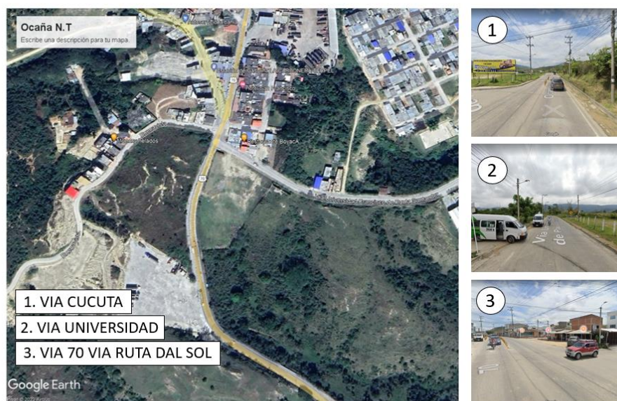
Figura 28. Mal estado de las vías cercanas al lote
