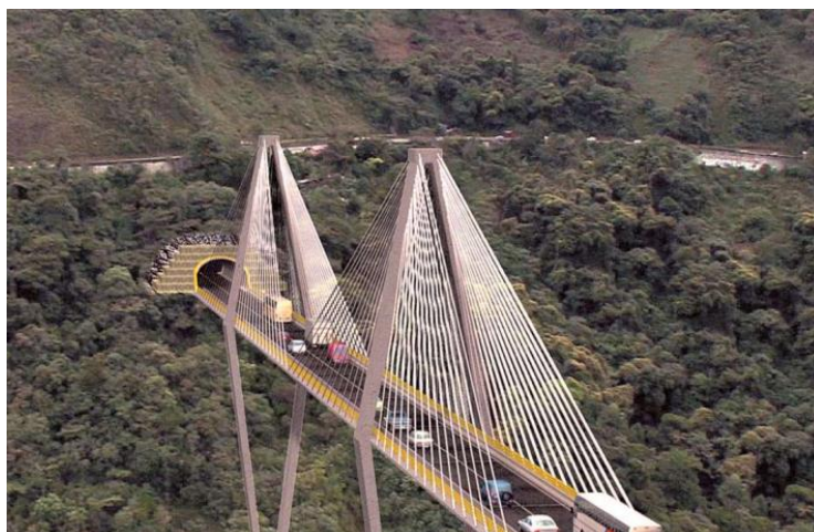
Figura 6 Futuro viaducto Chirajara vía Bogotá-Villavicencio
