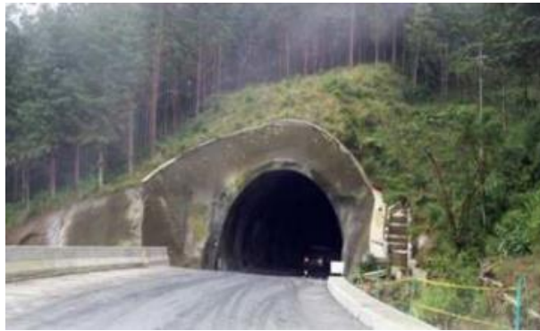
Figura 5 Túnel de Los Chorros
