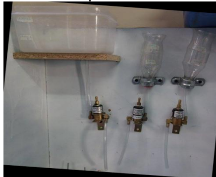
Figura 16. Sistema de electroválvulas para automatizar el sistema.
