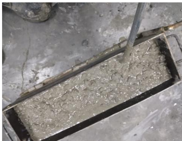
Figura 10. Fabricación de viguetas de concreto
