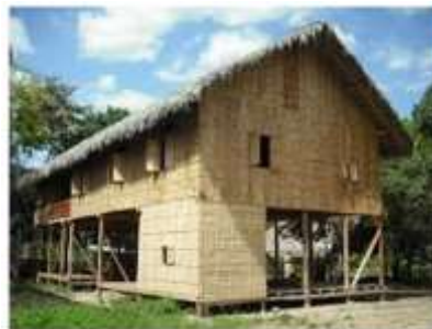
Ilustración 8 - Vivienda en caña (Guadua) Fotografía tomada en Manabí, Disponible en: construccion-viviendas-guido-poveda.pdf
