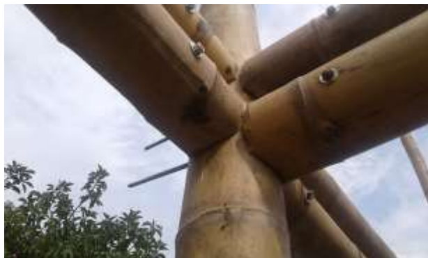
Ilustración 6 - UNION DE ESTRUCTURAS DE GUADUA, IMZA arquitectura, Disponible en: imzaarquitectura.com
