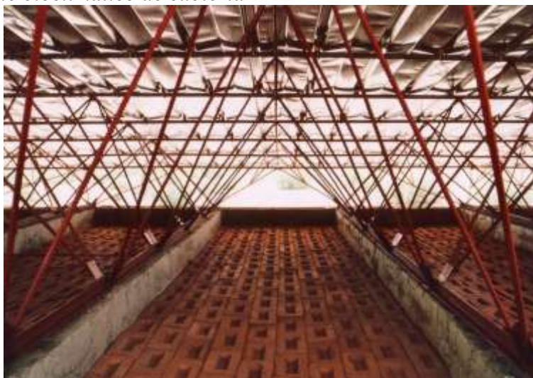
Figura 74. Detalle bioclimático de cubierta
