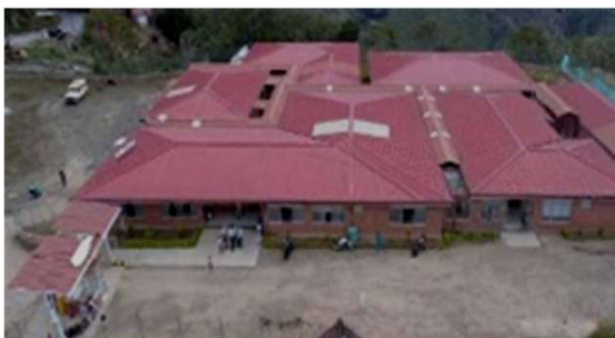
Imagen 28. Hospital reubicado en la zona baja sector el llano
