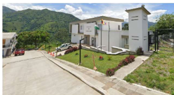
Imagen 30. Estación de policía reubicada en la zona baja sector el llano
