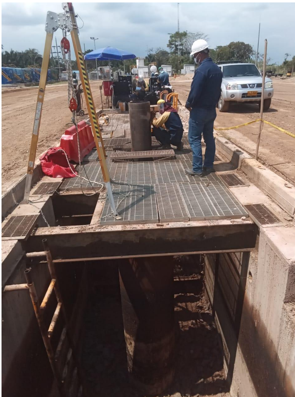
Nota: Trabajo metalmecánico en contrapozo REX-06
