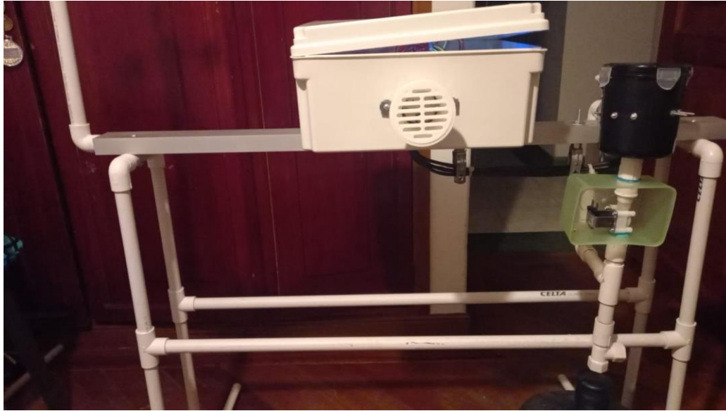
Ilustración 31. Estructura para la estación climatológica y calidad de agua.
