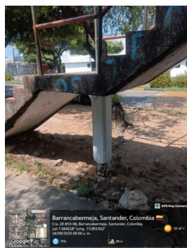
Foto 2. Apoyo del descanso de la escalera de acceso al puente.
