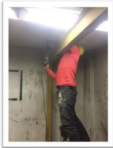
Figura 6. Montaje de nueva viga de izaje edificio Convida
