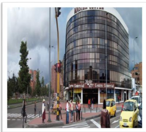
Figura 1. Edificio master center
