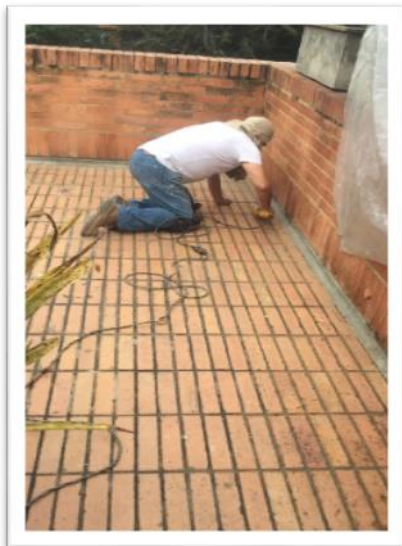
Figura 8. Impermeabilización terraza en adoquín edificio Juliana Calad
