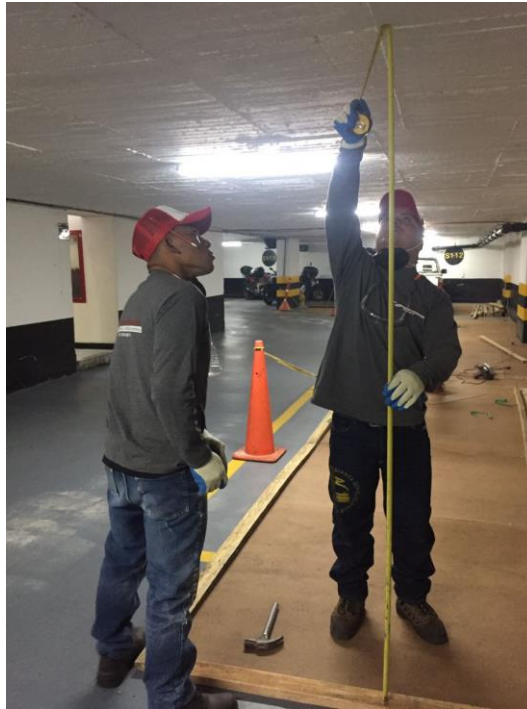
Figura 21. Inicio de obra preliminar cerramiento edificio Convida
