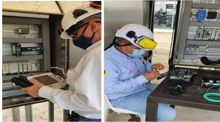
Figura 5: Acompañamiento en empalme de fibra óptica verificando que el procedimiento sea el adecuado y las pruebas sean las esperadas demostrando que no se tenga alguna pérdida de datos en los empalmes realizados.
