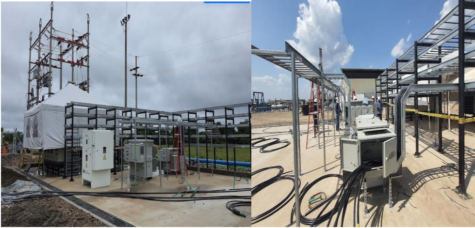
Figura 15: Ubicación de equipos en placa concreto, construcción de rack de bandejas para alimentación de los equipos.
