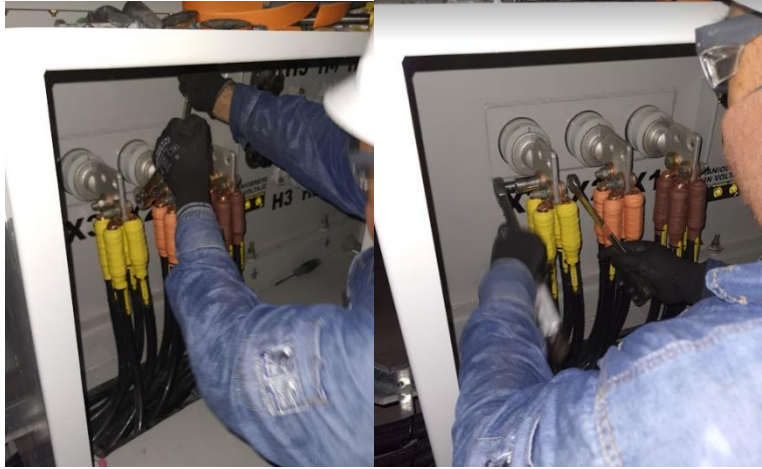
Figura 12: Pruebas realizadas con torquímetro de trinquete conexionado en los equipos, asegurando la fuerza que se aplica corresponda al torque dadas por el fabricante, según grado y diámetro del tornillo.
