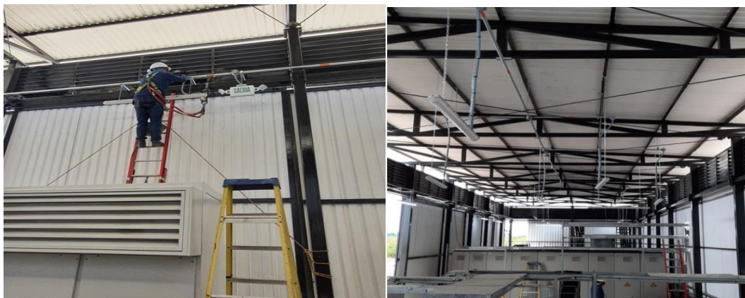
Figura 17: Construcción de iluminación en schelter para equipos de superficie, tableros de potencia y RTU
