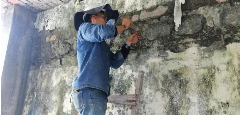
Figura 14 Ensayo de esclerometría en el sitio N° 2 placa Bloque Anterior
