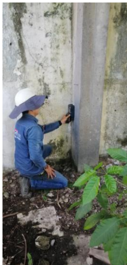
Figura 16 Ensayo de Ferroskan sobre columna en concreto
