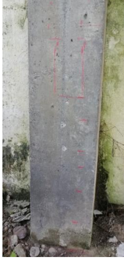
Figura 15 Ensayo de Ferroskan sobre columna en concreto
