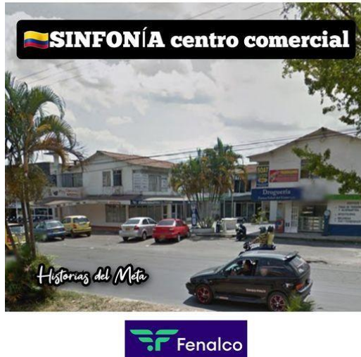
Figura 5 Centro Comercial Sinfonía, en uso, década del 2.000.
