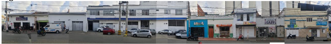
Figura 21. Fachadas Calle 28 estado actual
