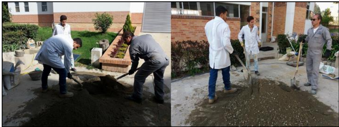
Fotografía 7. Proceso de mezclado manual del concreto.
