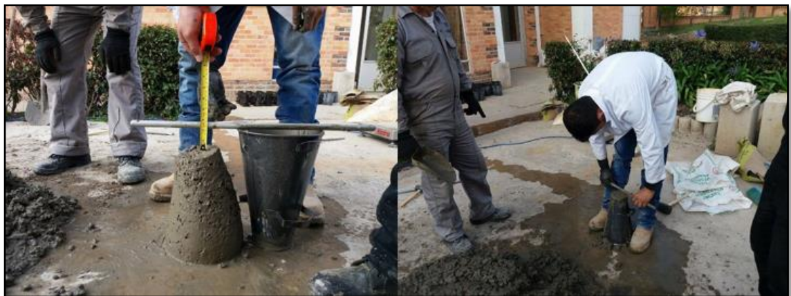
Fotografía 10. Prueba de asentamiento.
