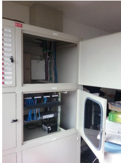
Figura 145. RAC de conexiones del Laboratorio.
