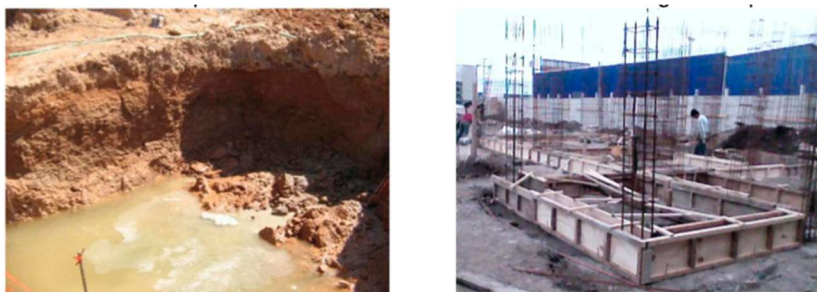
Figura 5. Inestabilidad en paredes y encofrado. Ver [9]
