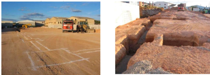
Figura 4. Excavación y solado. Ver [9]
