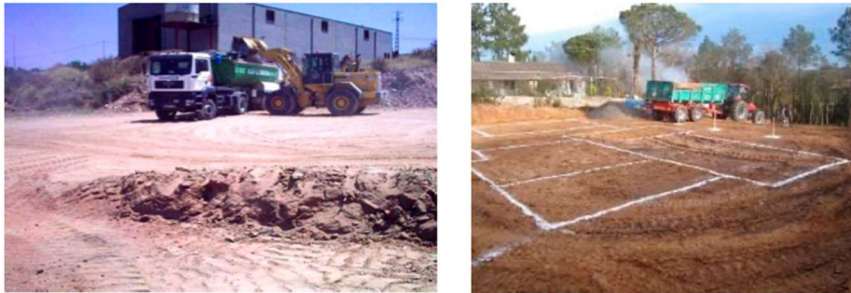
Figura 3. Replanteo y excavación. Ver [9]
