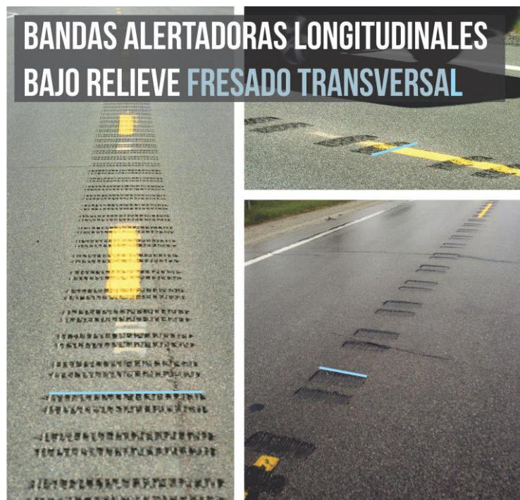
ILUSTRACIÓN 6. BANDAS ALERTADORAS LONGITUDINALES POR FRESADO. FUENTE: (MLIVE.COM, 2020)
