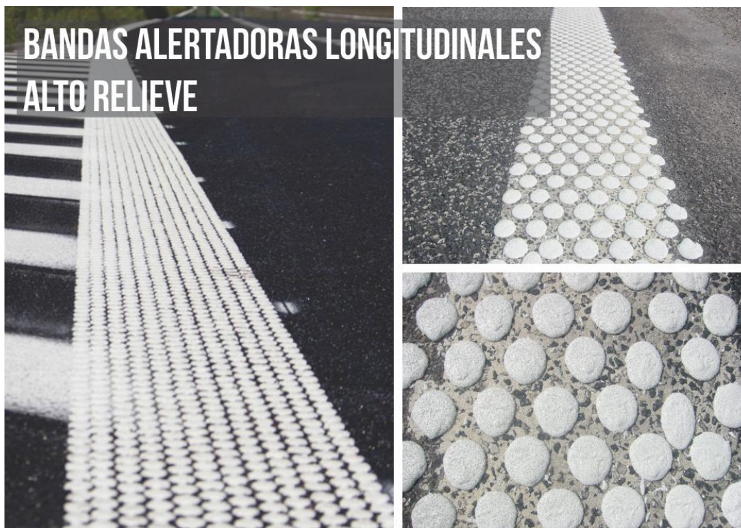
ILUSTRACIÓN 11. BANDAS ALERTADORAS LONGITUDINALES (BAL) CON PLÁSTICO. FUENTE: (BITULEIT, 2020)
