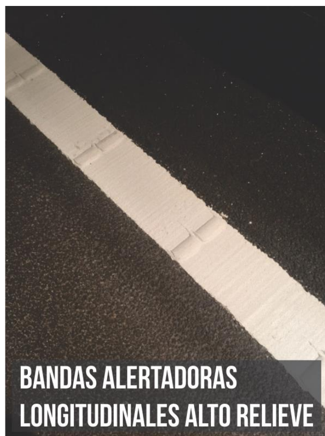
ILUSTRACIÓN 8. BANDAS ALERTADORAS LONGITUDINALES CON PLÁSTICO. FUENTE: (AMES, 2019)
