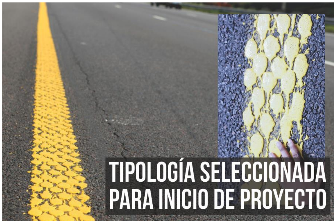
ILUSTRACIÓN 58. SEÑALIZACIÓN PINTURA TEXTURIZADA (IOL, 2022)
