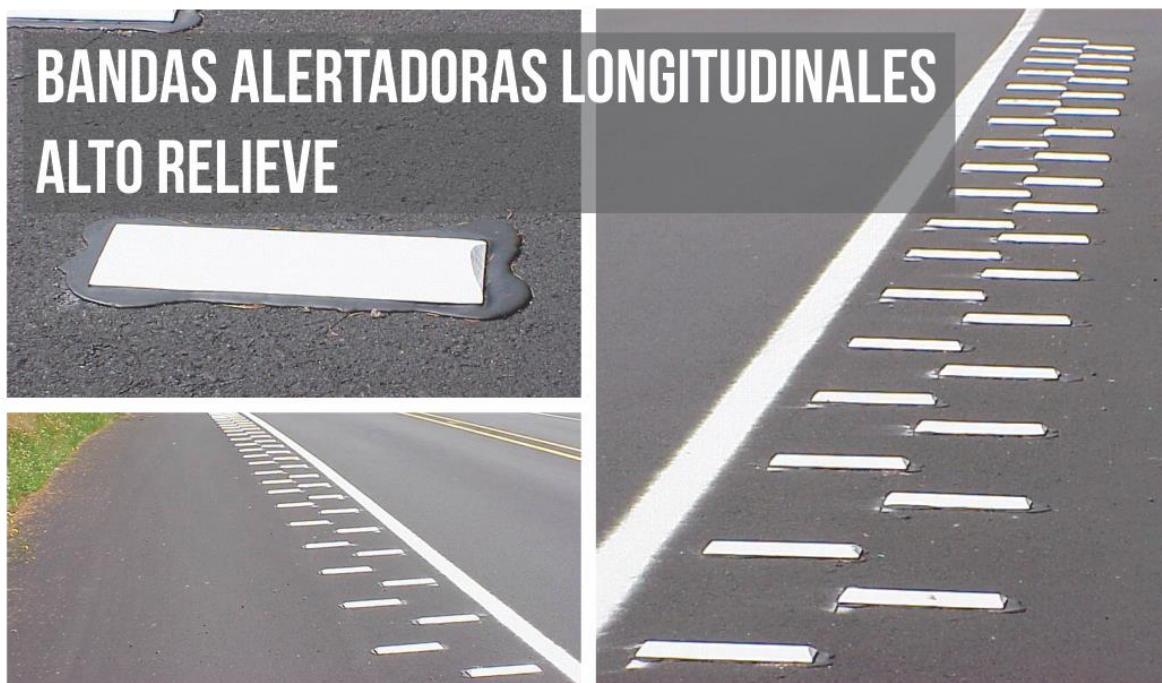
ILUSTRACIÓN 9. BANDAS ALERTADORAS LONGITUDINALES CON PLÁSTICO. FUENTE: (PEXCO, 2020)
