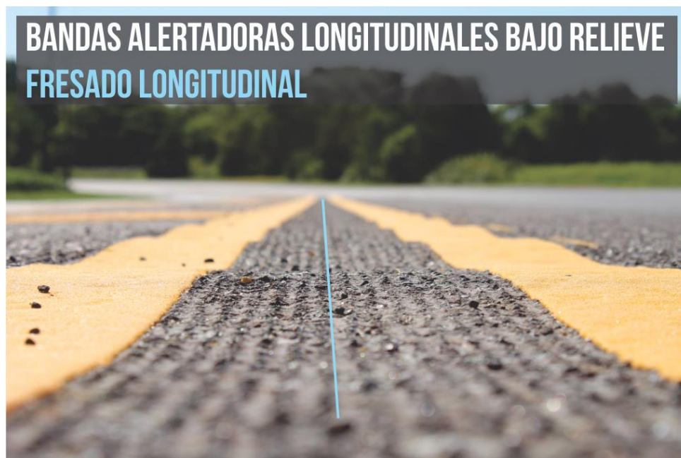
ILUSTRACIÓN 7. BANDAS ALERTADORAS LONGITUDINALES POR FRESADO. FUENTE: (BRIDOG, 2020)
