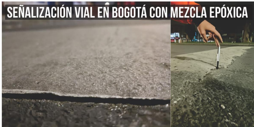
ILUSTRACIÓN 57. SEÑALIZACIÓN CON EPOXICOS (FUENTE: PROPIA)
