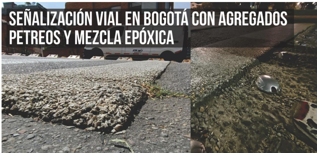
ILUSTRACIÓN 55. EJEMPLO DE SEÑALIZACIÓN VIAL EN BOGOTÁ POR USO DE MEZCLA DE MATERIALES PETREOS Y EPOXICOS (FUENTE: PROPIA)
