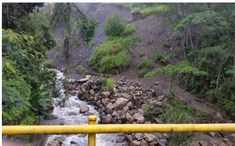
Fotografía 38 Trinchos quebrada chigüanza
