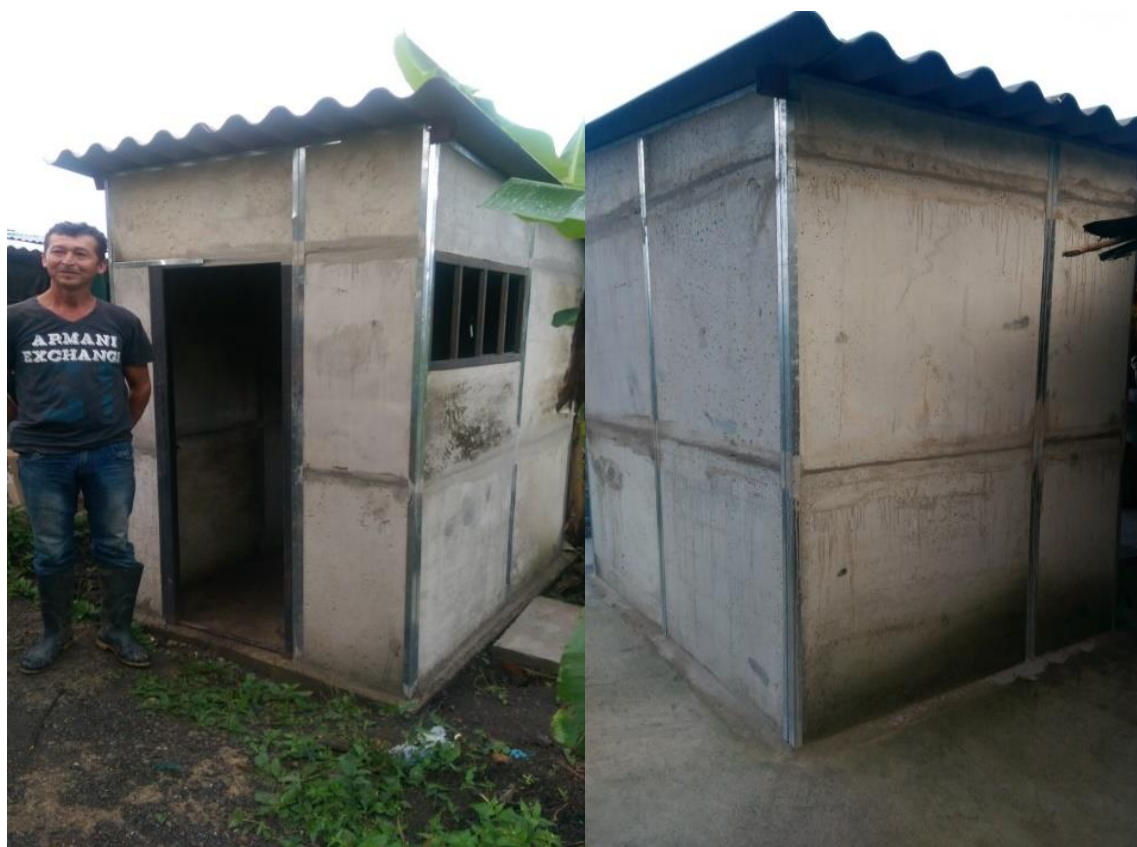
Fotografía 7 Caseta sanitaria UNISAFA
