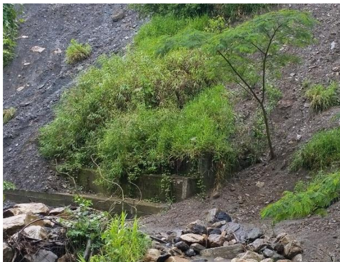
Fotografía 31 Trinchos quebrada chigüanza
