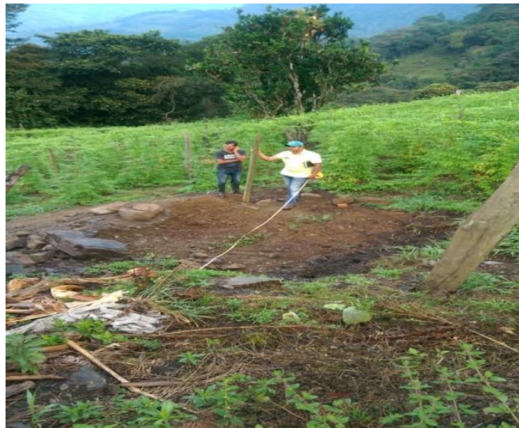
Fotografía 5 Ubicación de pozo séptico
