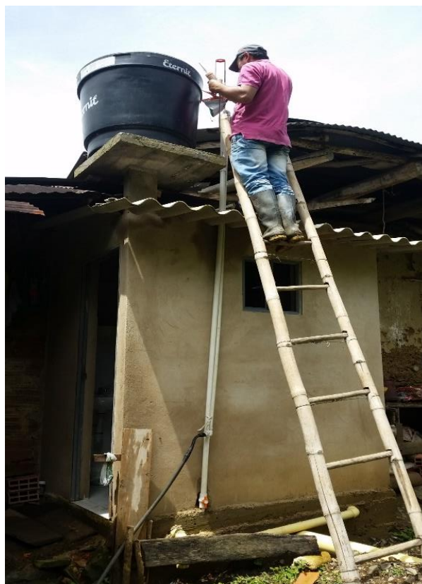
Fotografía 34 Instalación de tanque elevado
