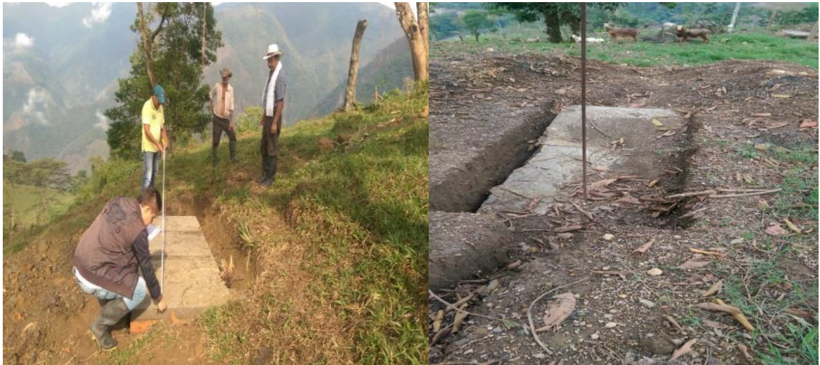
Fotografía 6 Verificación de medidas de los pozos.
