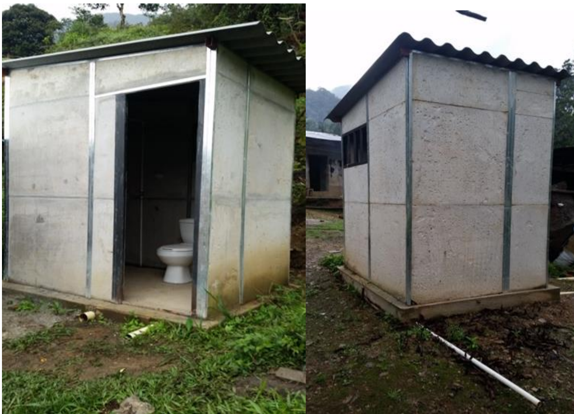
Fotografía 32 Casetas sanitarias sin conexión de agua potable
