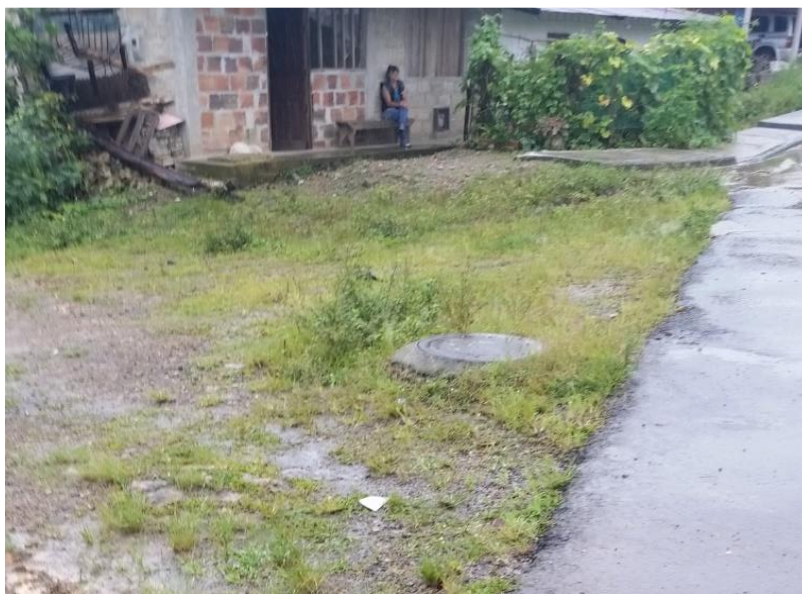
Fotografía 24 Pozo de inspección carrera 7, vía sin pavimentar
