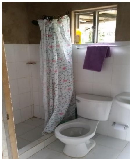
Fotografía 16 Interior unidad sanitaria
