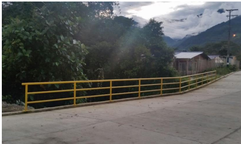
Fotografía 13 Baranda terminada car3 vía al colegio
