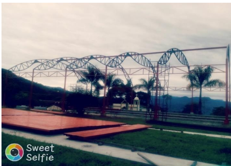
Fotografía 26 Estructura cubierta cancha múltiple
