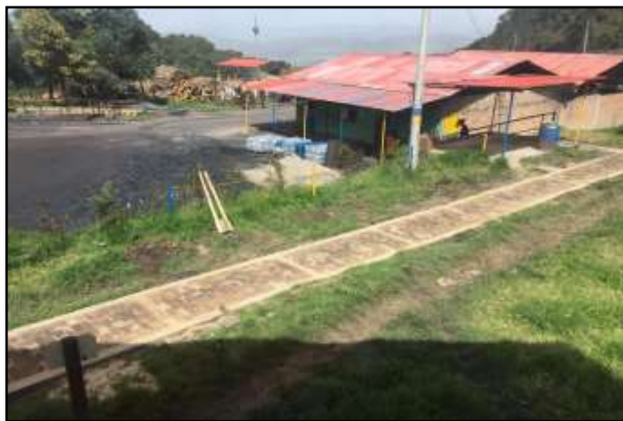
Ilustración 14 Proceso de adoquín del sendero peatonal
