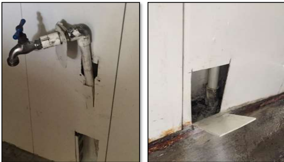
Ilustración 26 Inspección tubería baños hombre
