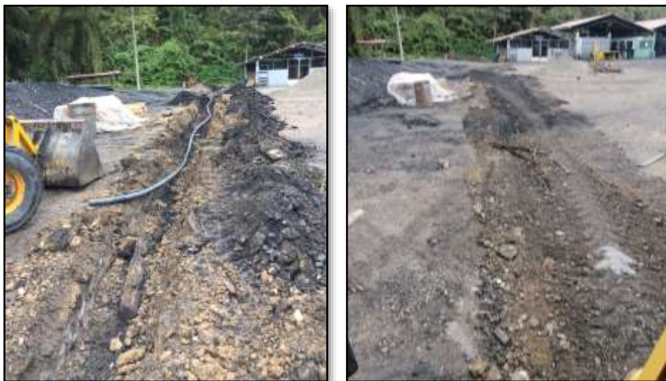
Ilustración 18 Instalación de tubería y relleno de zanja.
