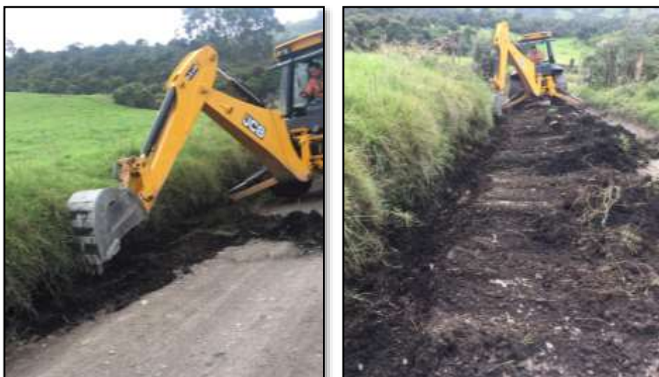
Ilustración 19 Construcción de cuneta primer tramo
