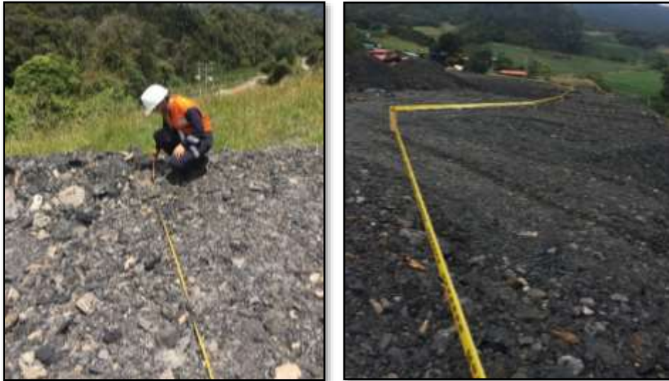
Ilustración 21 Replanteo nueva terraza botadero
