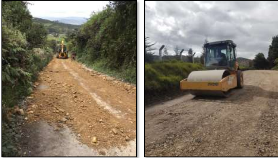
Ilustración 20 Descargue y compactación de recebo en un tramo de la vía
