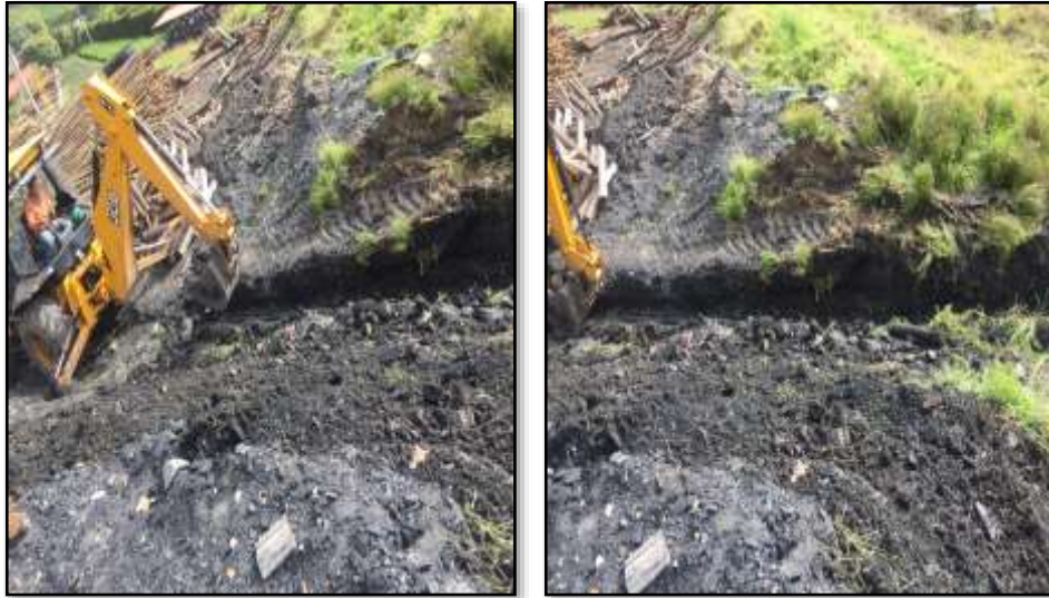
Ilustración 17 Limpieza de cuneta ubicada al costado del botadero
