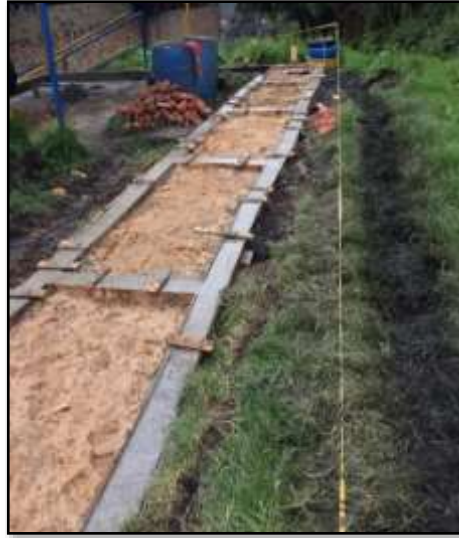
Ilustración 13 Vaciado del concreto
