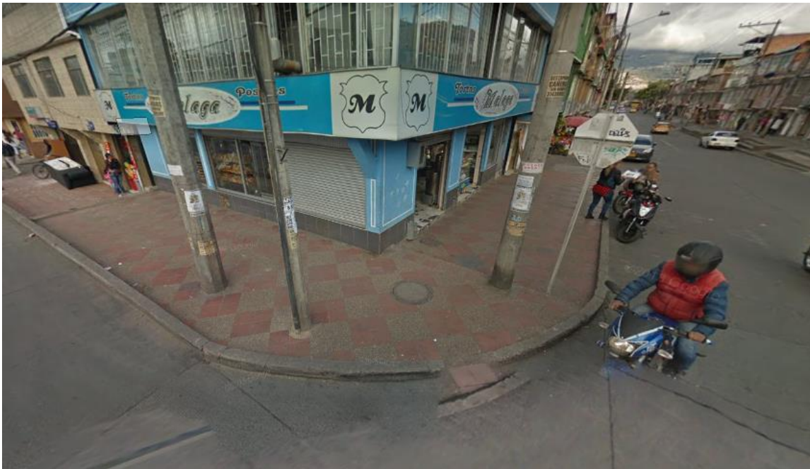
Figura 65. Intersección andenes (esquina).
