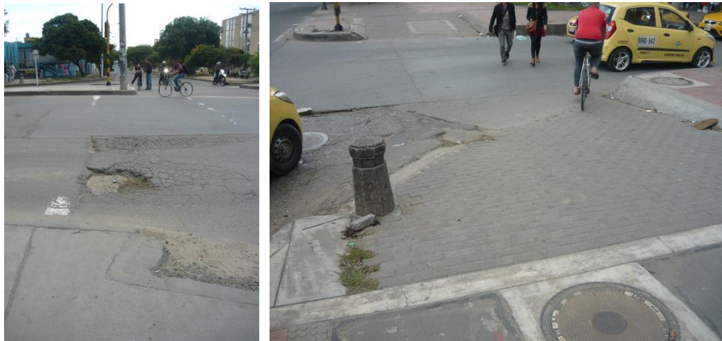
Figura 33 . Condiciones vías vehiculares para lista de chequeo.
