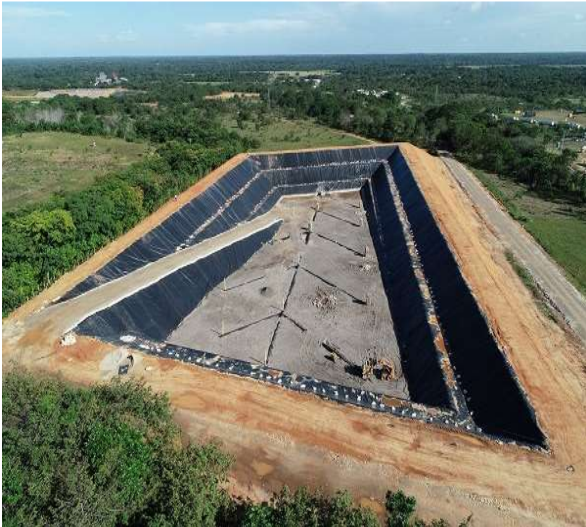
Figura 1. Relleno sanitario tipo trinchera.
