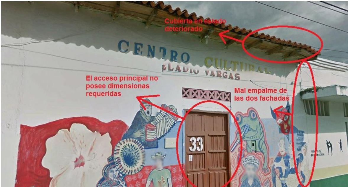
Figura 1 Adaptada de Google Earth. Actual casa de la cultura de Aguachica, Cesar. Aquí podemos observar las falencias que se hallan en la actual casa de la cultura.
